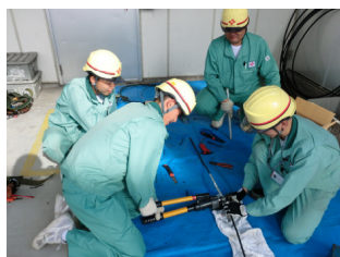
四国電力(株)坂出営業所
