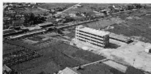
第1期工事完了
