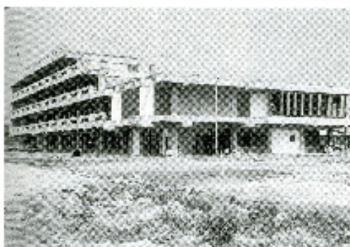
第2期工事の終わった本館
