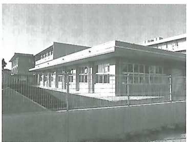
完成した工業科棟(東側から)
