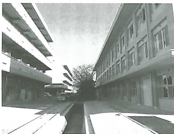
西側から正門方向を望む 左(奥本館、手前 実習棟)、右(工業科棟)
