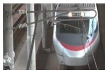
大浦通り跨線橋
