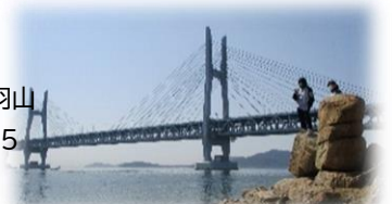
櫃石島斜張橋
