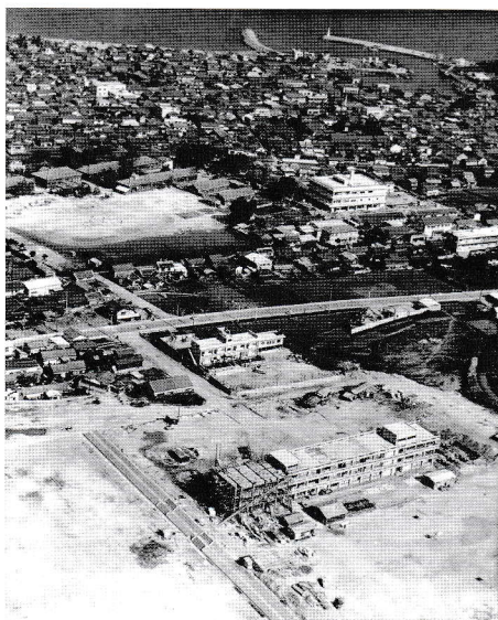
1964年 旧校舎と建設中の新校舎
