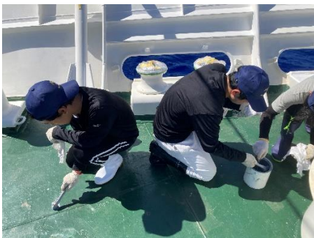
錆び止め塗装
